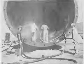
TA PARCE manera un operacion sin fin, pero sandblasters ta want'e calma. E seccionnan di paden mester worde trata asina cu un gunnite lining por worde instala.
